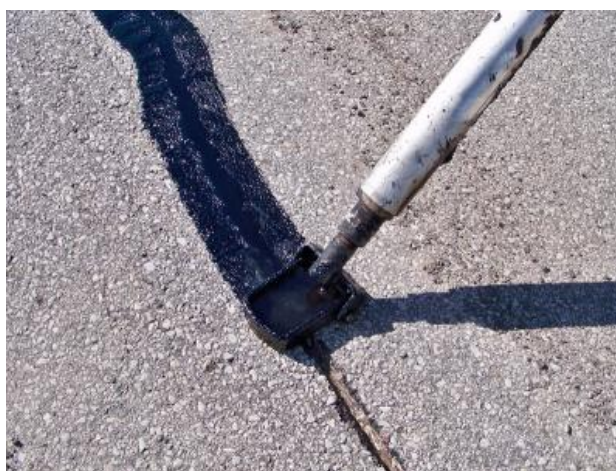
圖 2.2-1 裂縫填縫
