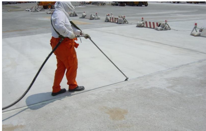
圖 3.2-1 填縫材料更新
