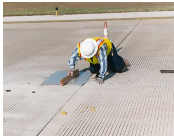
圖 3.2-10 部分深度修復(區塊修補)
