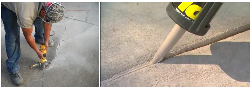
圖 3.2-4 裂縫填縫
